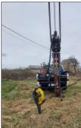
Foto 1. Aspectul terenului studiat cu instalația de foraj geotehnic utilizat.
